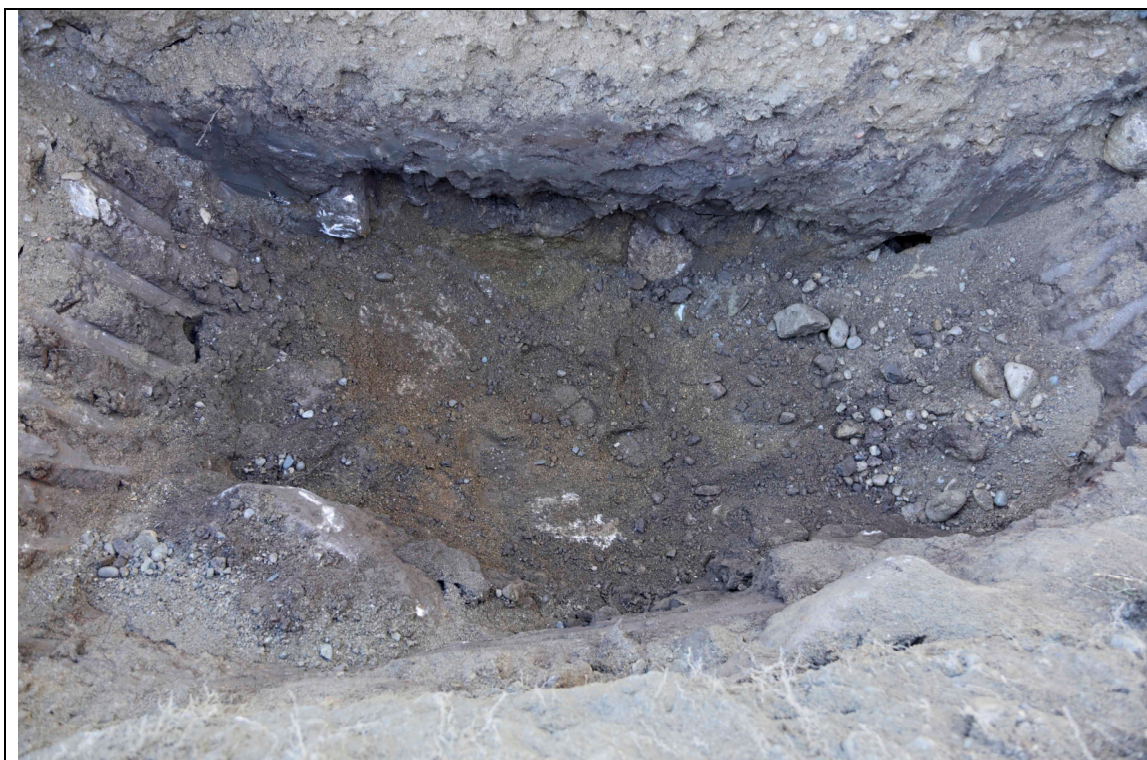
Foto n. 5 – Pozzetto SW . Si osservino i trovanti di grosse dimensioni che impediscono di proseguire l'escavazione
