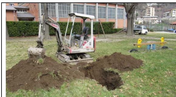
Foto n.4 - pozzetto esplorativo escavato in corrispondenza dell'area adibita a parco giochi . La profondità raggiunta è stata di circa 1.2 m dal p.c. ; a tale quota si osserva la transizione dal terreno vegetale ai materiali di riporto messi a dimora a seguito della bonifica dell'antica area cimiteriale .
