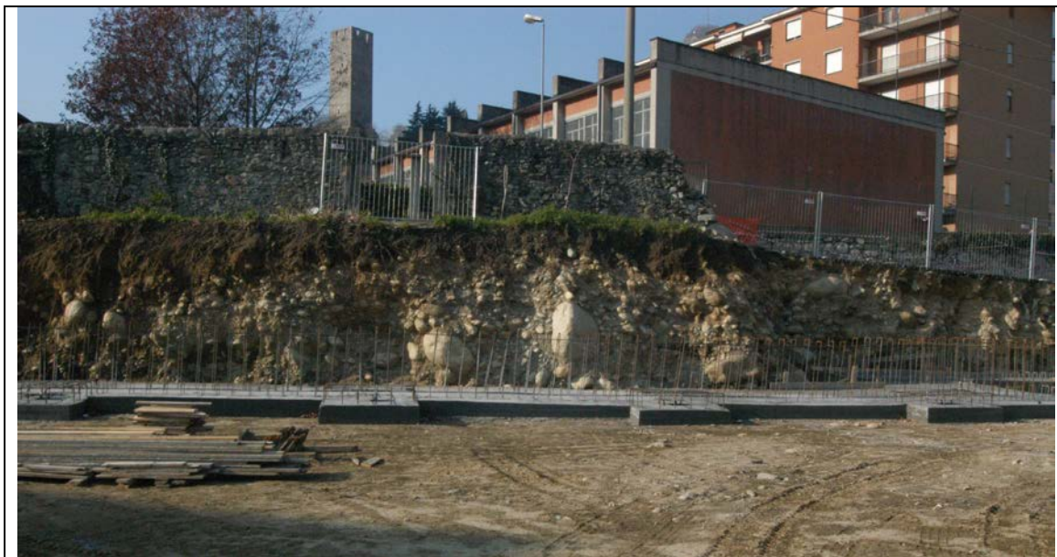
Foto n.3 – Struttura dei depositi fluvioglaciali in adiacenza all'area di intervento (scavo di sbancamento per la costruzione del Salone polivalente) . Si osservi la notevole eterometria del deposito determinata dalla sedimentazione in ambiente torrentizio . I materiali di riporto sovrastanti il deposito naturale tendono ad approfondirsi procedendo verso via Roma (a sinistra) e verso l'area di intervento (a tergo del muro in pietra)
